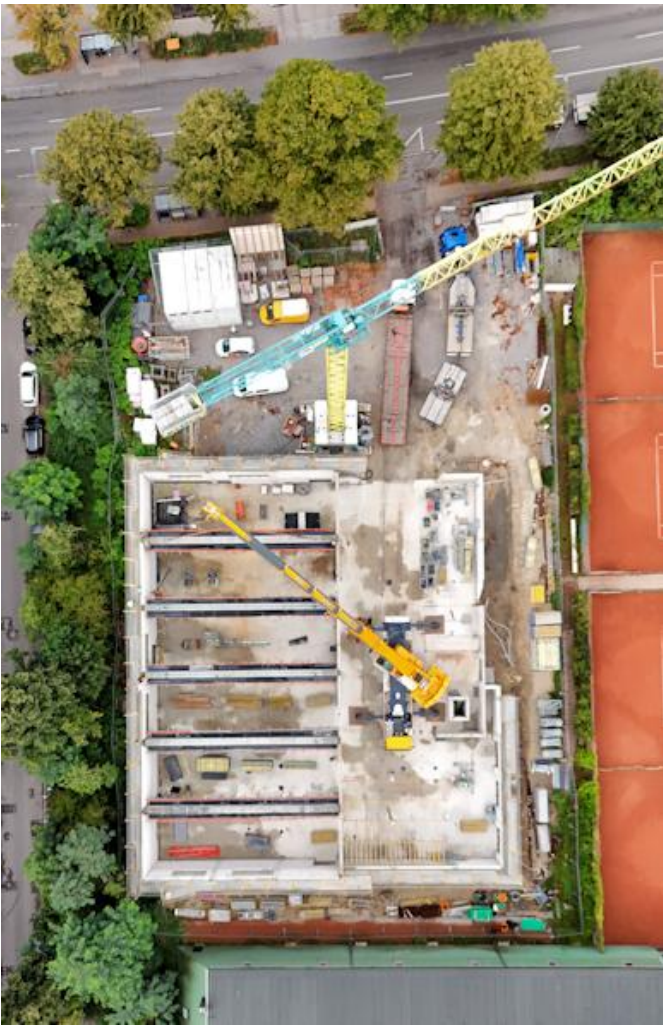
Stand der Baustelle 02.09.2025
