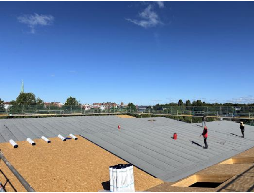
Stand der Baustelle 07.05.2026
