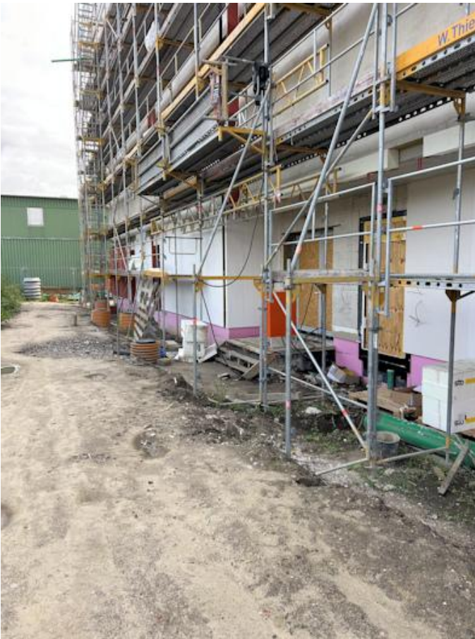
Stand der Baustelle 10.09.2026
