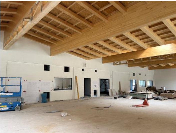
Stand der Baustelle 18.08.2026
