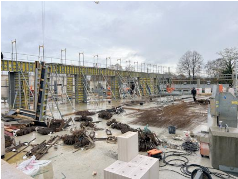
Stand der Baustelle 18.11.2025
