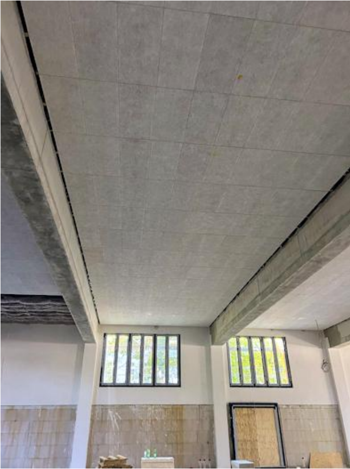
Stand der Baustelle 24.09.2026
