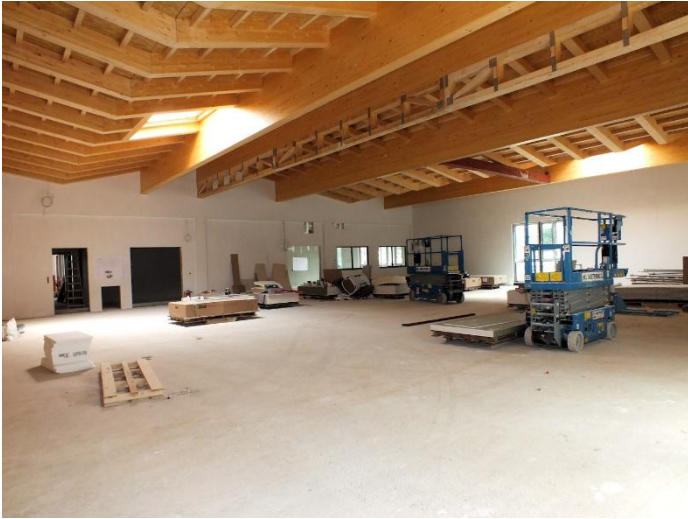
Stand der Baustelle 29.07.2026
